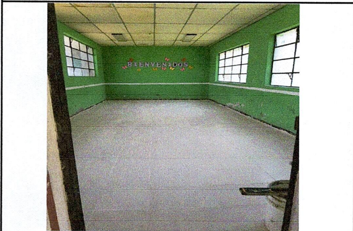
Foto 3: Cambio de piso en aula de modulo III
