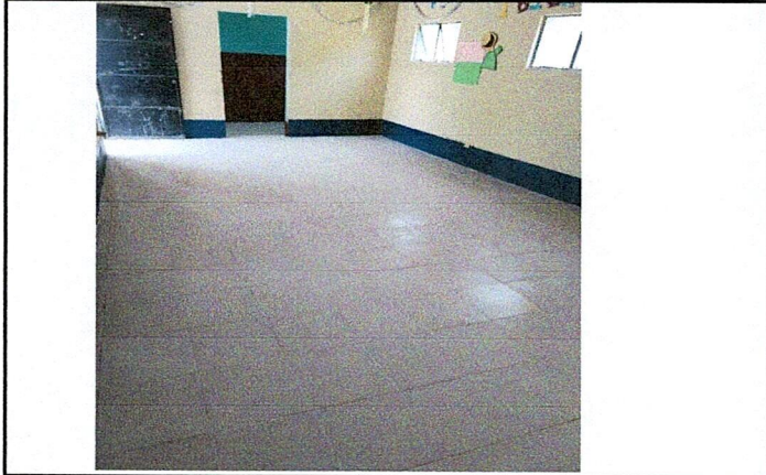
Foto 1: Cambio de piso en aula modulo I
