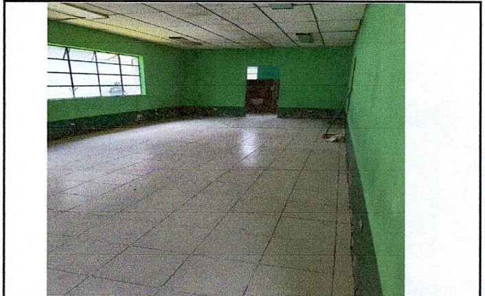
Foto 2: Cambio de piso en aula de modulo II
